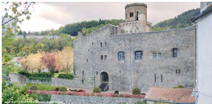
Rénovation du Prieuré par un opérateur privé
