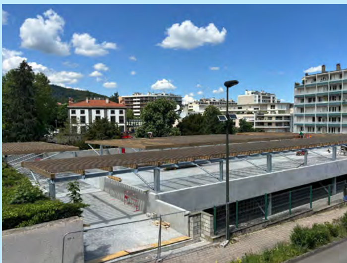
Les travaux en mai 2025
