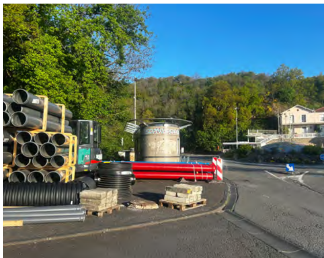
Travaux au niveau du rond-point du Breuil - avenue du Puy-de-Dôme
