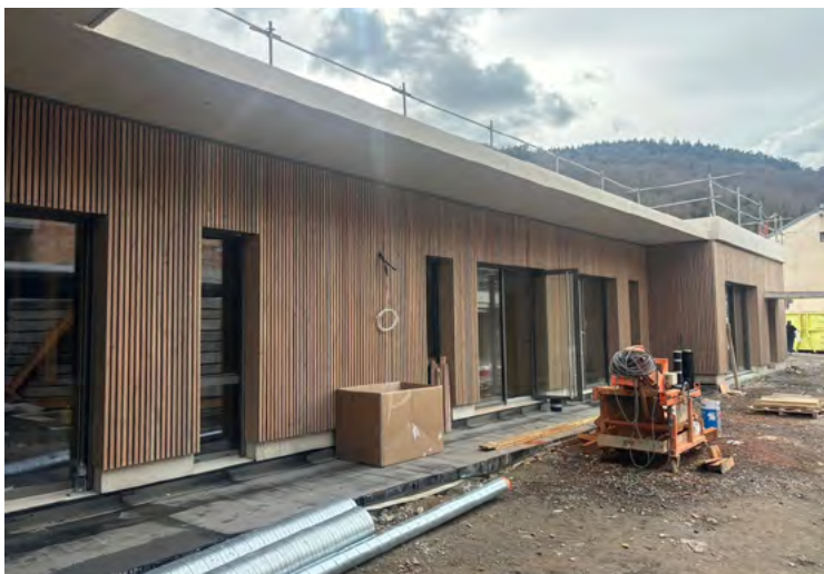
En chantier : les espaces de vie depuis le patio
