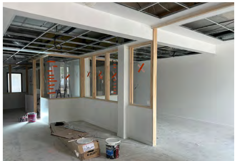
En chantier : un espace de vie divisible via une cloison coulissante
