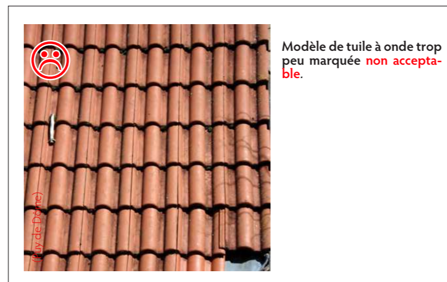
Pour être acceptable, la tuile romane doit présenter une onde forte qui l'assimile visuellement à la tuile creuse traditionnelle, et un couvert incurvé de forme trapézoïdale (et non rectangulaire).
