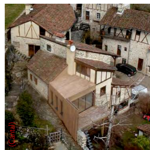
Mais, selon les cas, une compatibilité de matériaux différents (ici le bois et la maçonnerie traditionnelle) peut se révéler positive.
