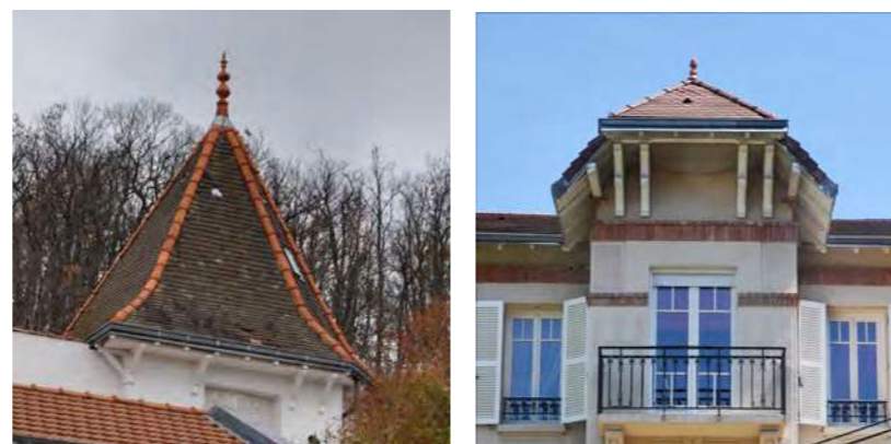
Les matériaux marginaux, comme la tuile plate petit moule, doivent être préservés et remplacés à l'identique. Ils sont bien souvent indissociables des architectures qui les ont mis en œuvre.
