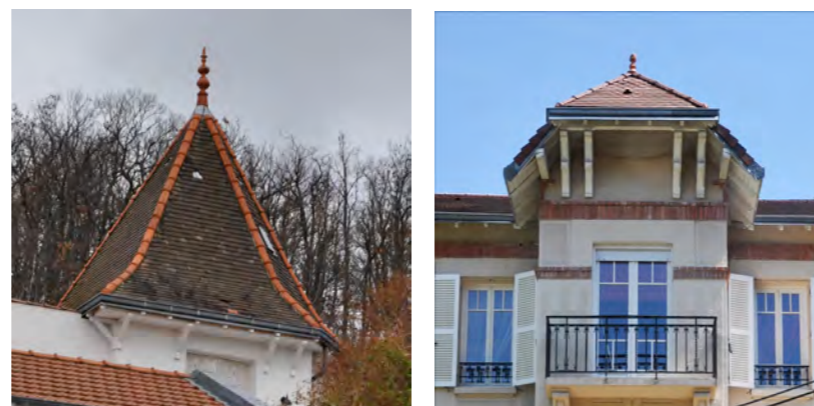
Les matériaux marginaux, comme la tuile plate petit moule, doivent être préservés et remplacés à l'identique. Ils sont bien souvent indissociables des architectures qui les ont mis en œuvre.
