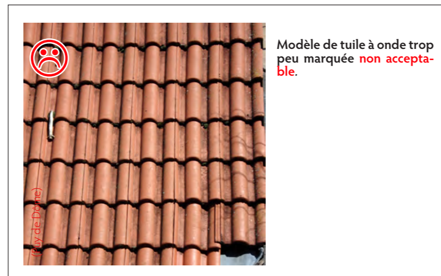
Pour être acceptable, la tuile romane doit présenter une onde forte qui l'assimile visuellement à la tuile creuse traditionnelle, et un couvert incurvé de forme trapézoïdale (et non rectangulaire).
