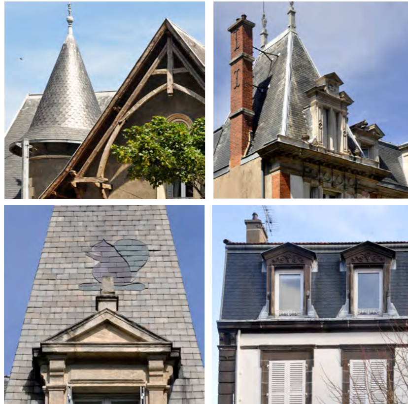
L'ardoise (à l'origine probablement angevine) est non seulement un matériau, mais aussi un ensemble de savoir-faire qu'il convient de préserver.
