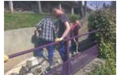
Travaux de rénovation d'un chemin. Parc thermal.
