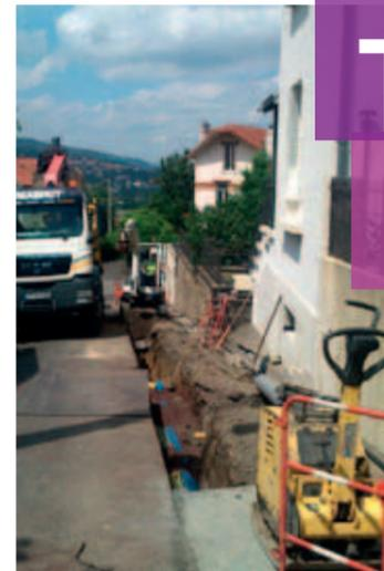
Rue Hippolyte Mallet: pose d'une conduite eau potable en fonte sur une longueur de 120 m et d'un poteau d'incendie pour assurer la défense incendie de la partie haute de cette rue
