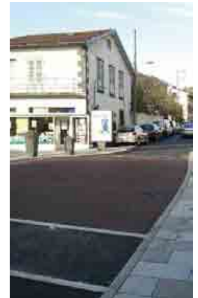
Place Clausat après les travaux
