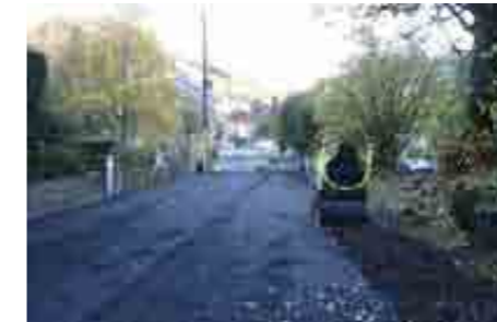
Rue de la Chapelle pendant les travaux
