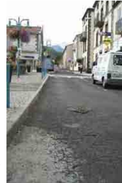
Place Clausat avant les travaux
